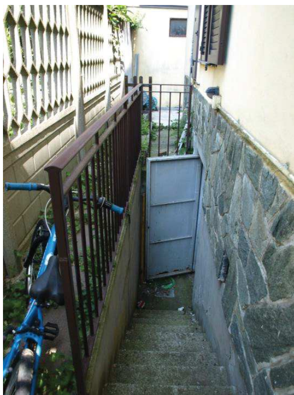
SCALA INGRESSO CANTINA
